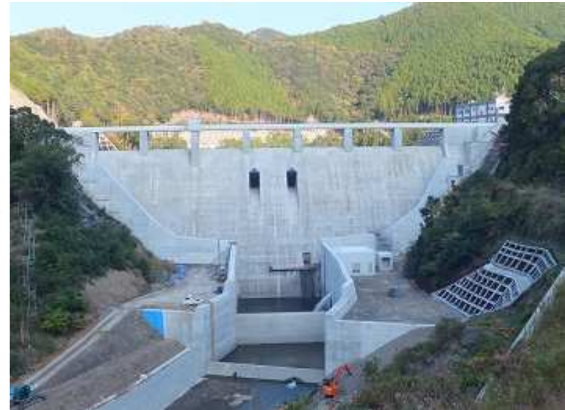
平成26年 11月 (堤内仮排水路部施工中)
