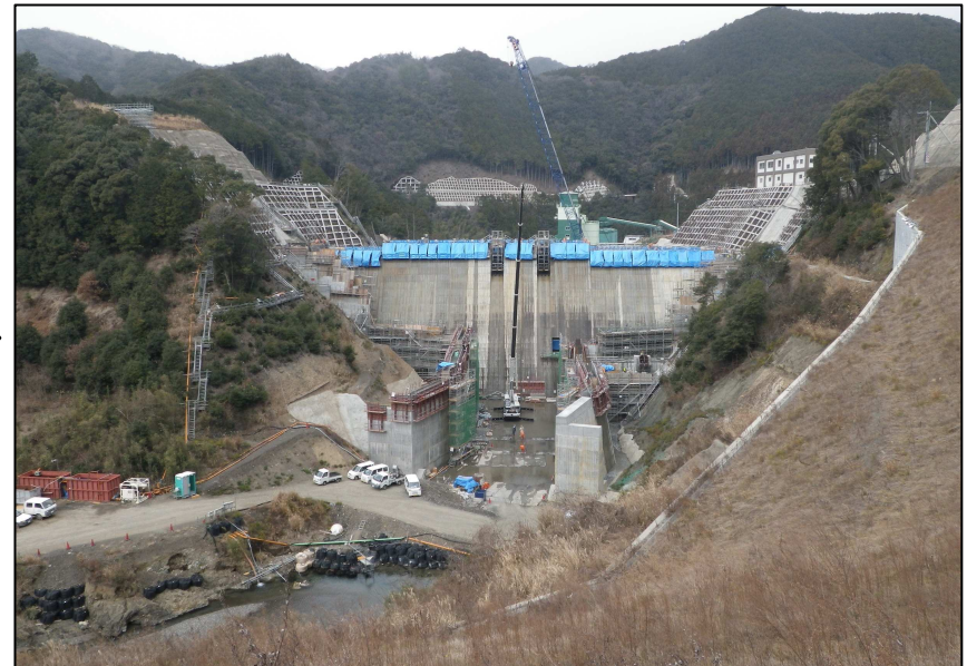
平成26年1月 (本体コンクリート打設中)
