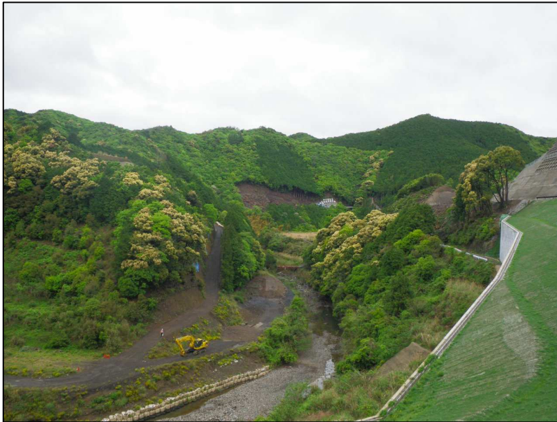
平成24年 5月 (ダムサイト伐採開始)
