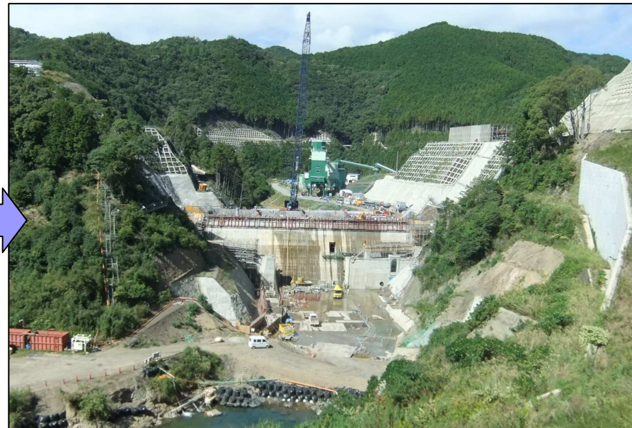
平成25年 9月 (本体コンクリート打設中)
