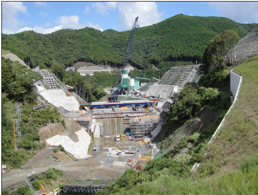
平成25年 8月（本体コンクリート打設中）
