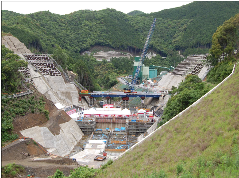
平成25年 6月（本体コンクリート打設中、定礎式）
