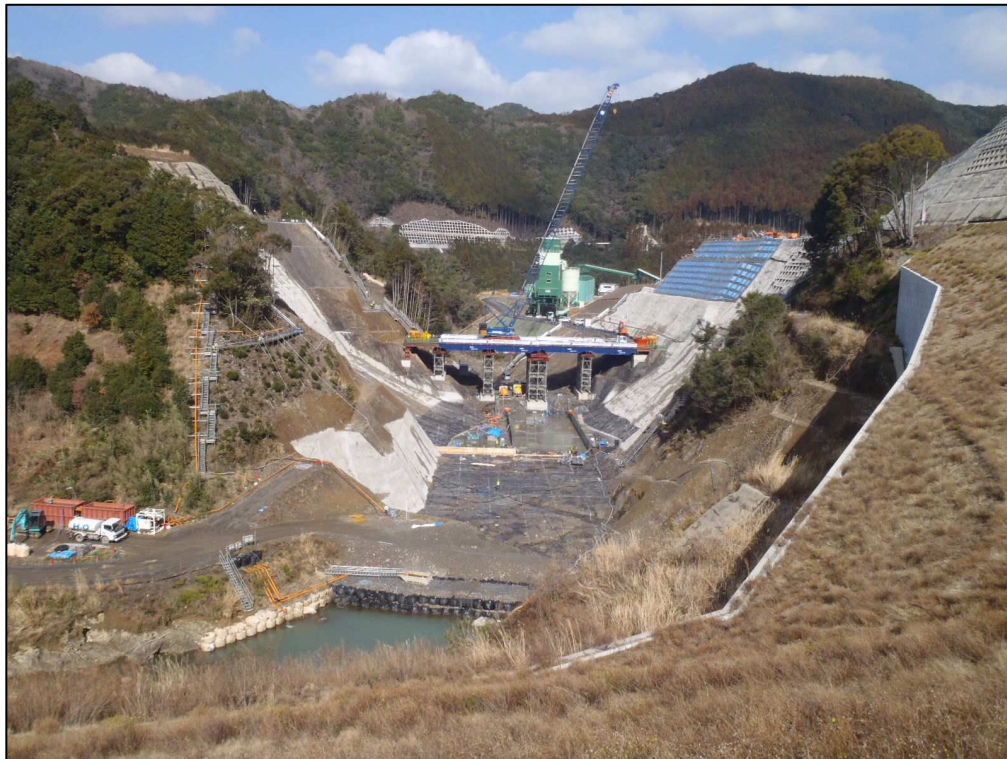
平成25年 2月（本体コンクリート打設開始）
