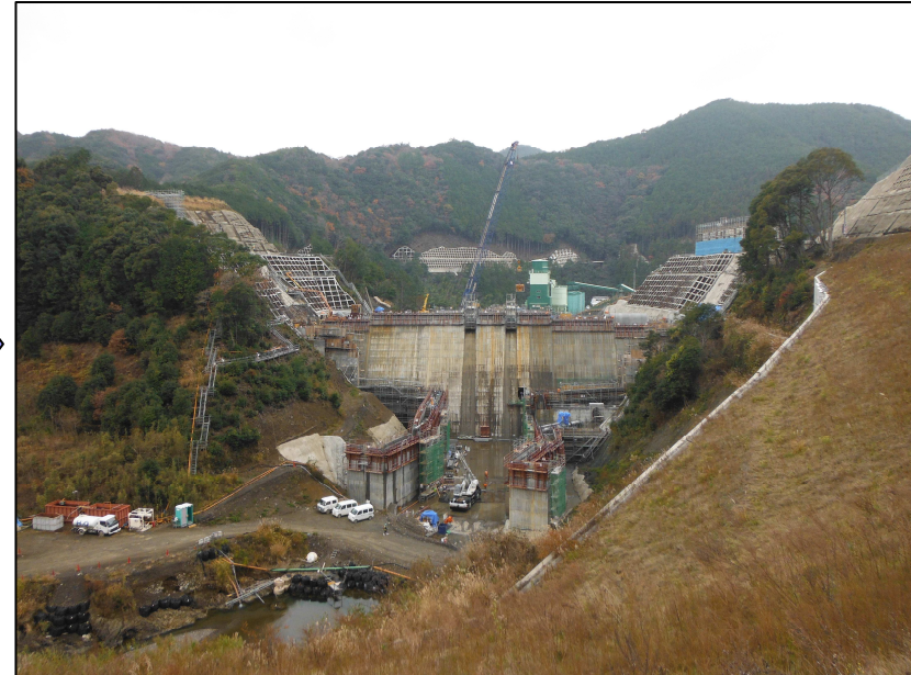
平成25年12月 (本体コンクリート打設中)
