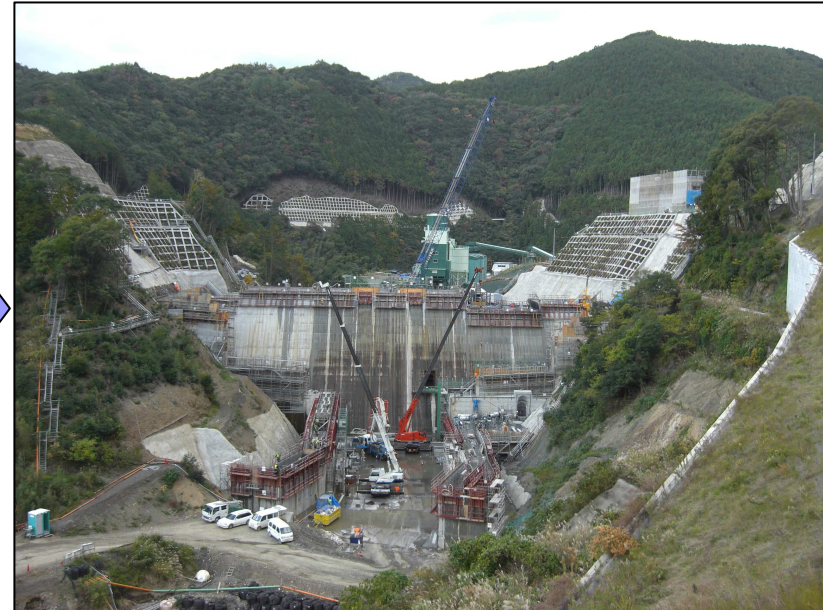
平成25年11月 (本体コンクリート打設中)
