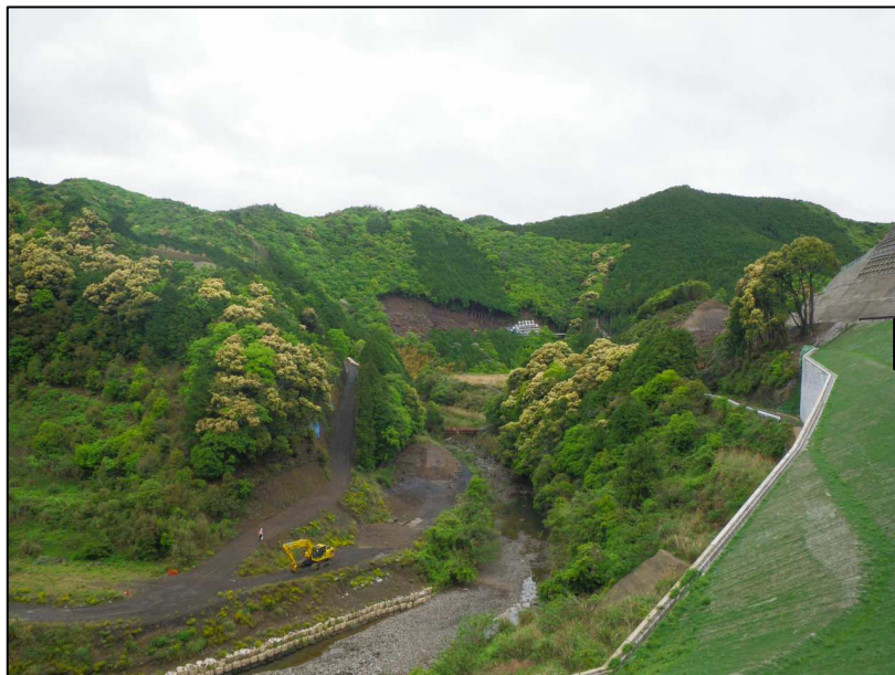
平成24年 5月 (ダムサイト伐採開始)
