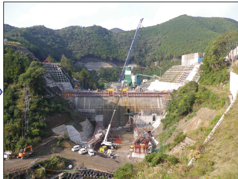
平成25年10月 (本体コンクリート打設中)
