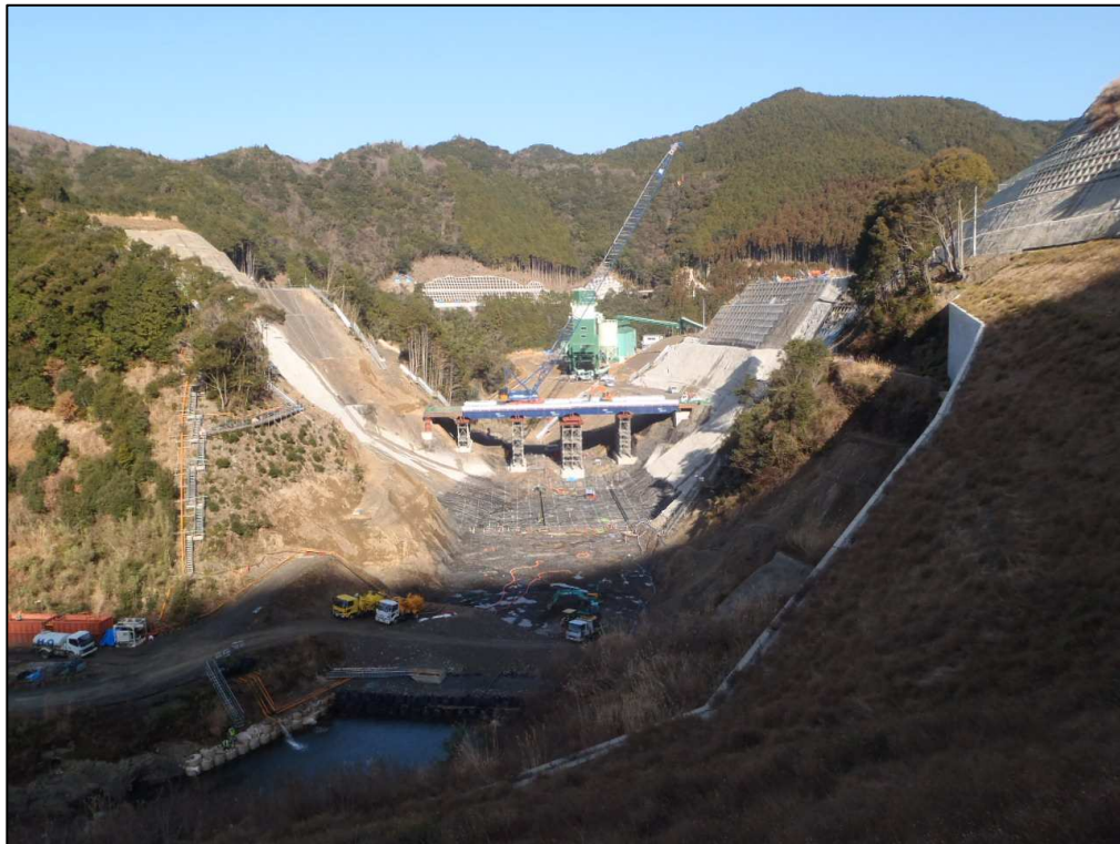
平成25年 1月（地盤確認、仮設ステージ設置完了）
