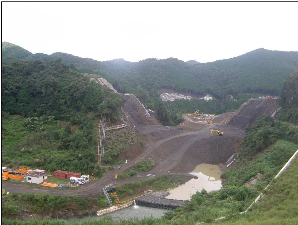
平成24年 9月 (基礎掘削工 施工中)
