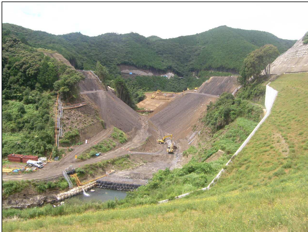
平成24年 8月（基礎掘削工 施工中）
