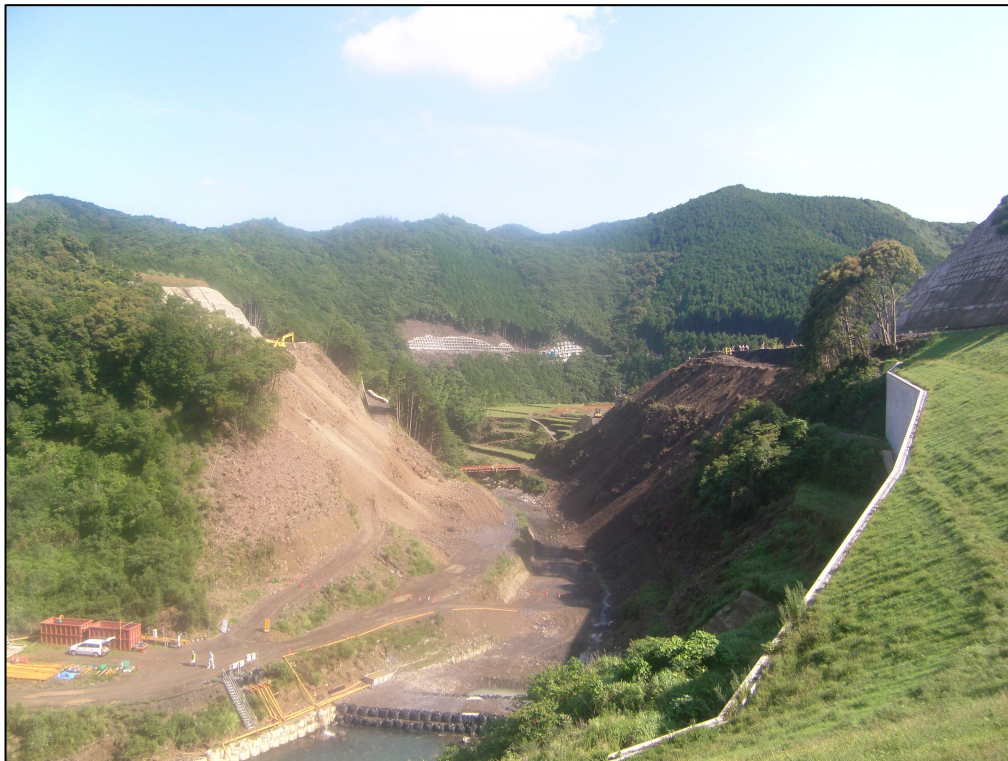
平成24年 7月（基礎掘削工 施工中）
