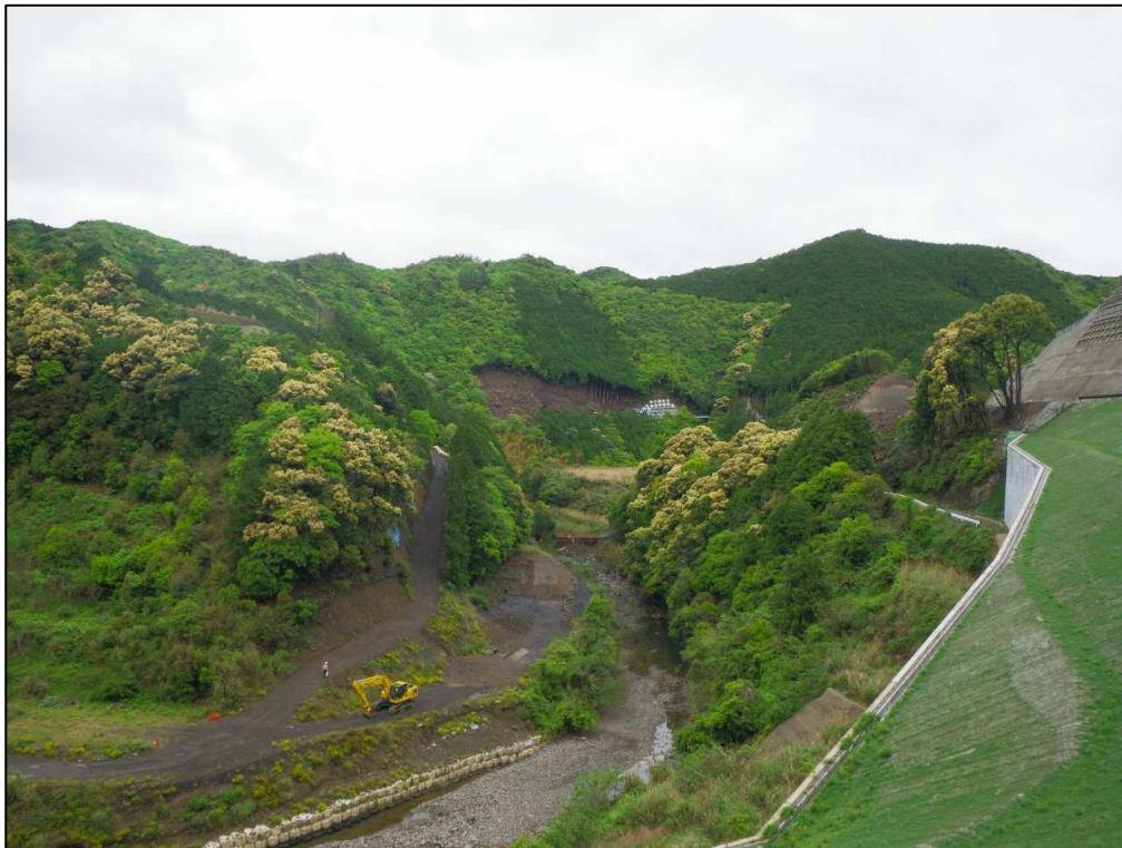
平成24年 5月（ダムサイト伐採開始）
