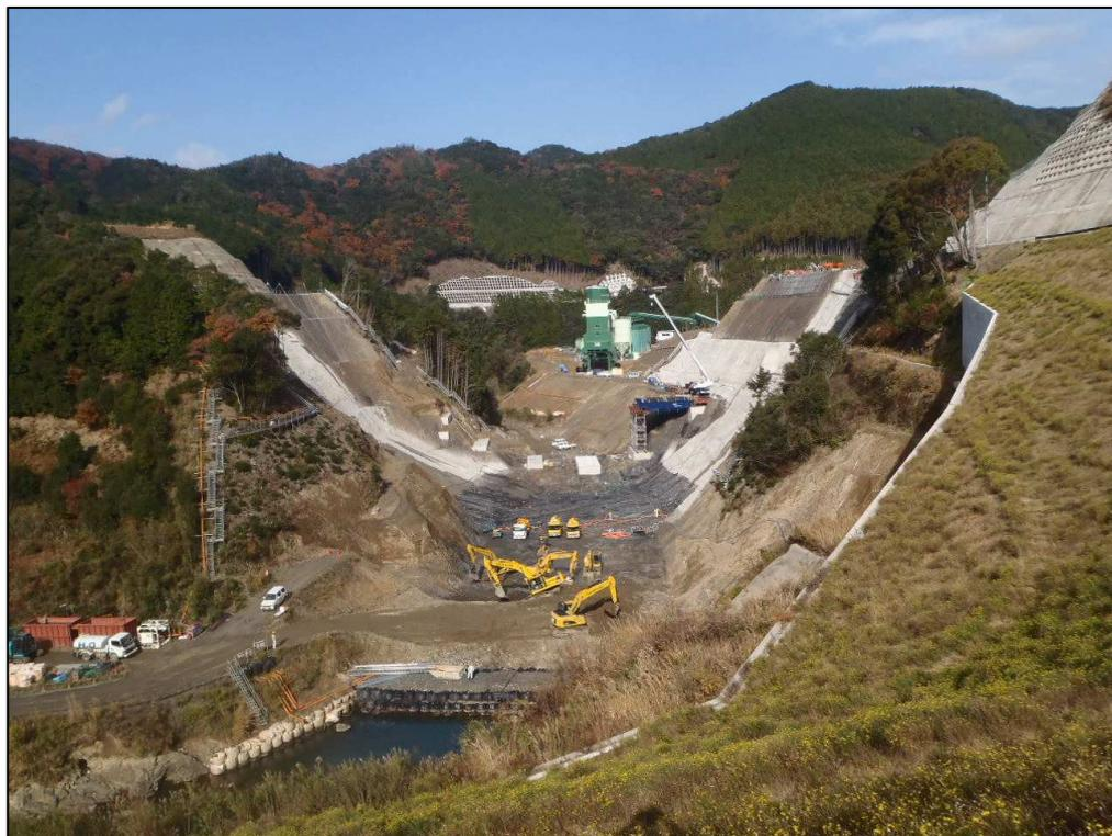
平成24年12月（基礎掘削工完了、コンクリートプラント設置完了）
