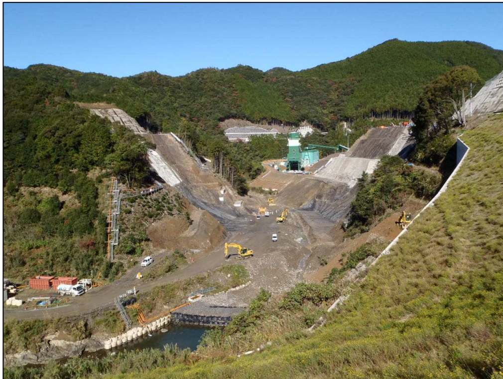
平成24年11月(基礎掘削工施工中、コンクリートプラント設置中)
