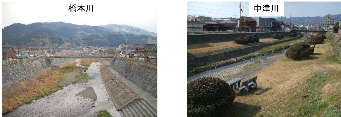
図 2.2.2.4 環境に配慮した護岸整備状況
