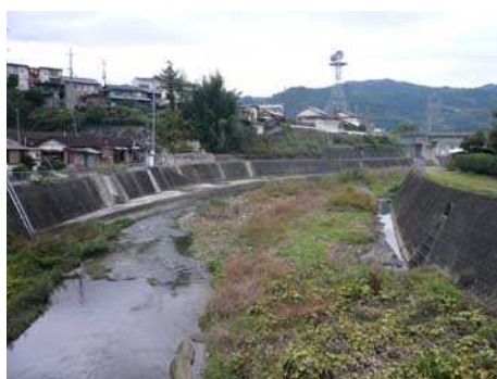
みとの橋水位観測所付近下流 (0.6k)
