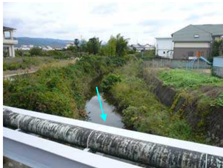
地藏寺橋(3.0k付近)から上流
