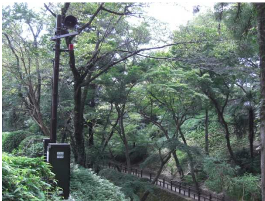
警報装置設置例(根来川支川 大谷川)
