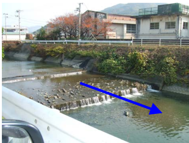
1k520 付近(大湯井堰付近)
