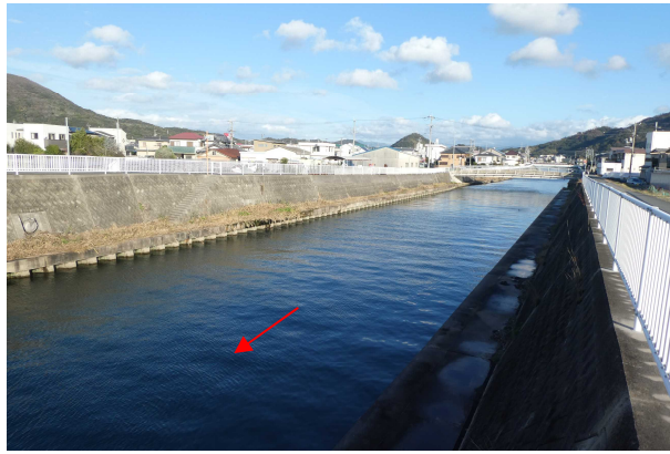
図 7 亀の川河口（0.0k 付近から上流）
