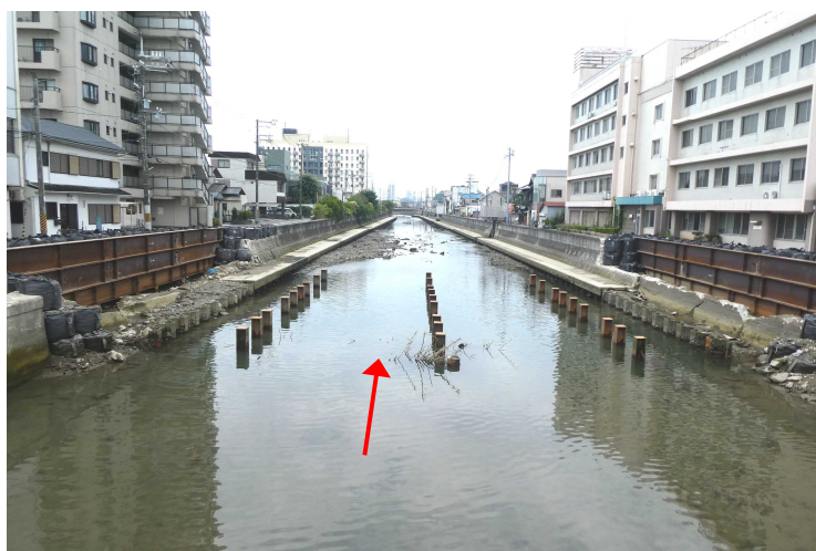
図 4－4 0.6k 付近（新町橋から下流側を望む）
