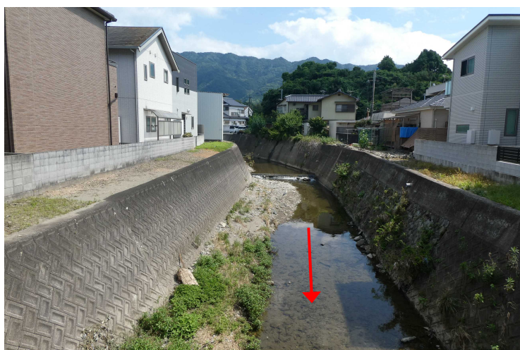
図4-8 2.1k付近（大坪橋から上流側を望む）
