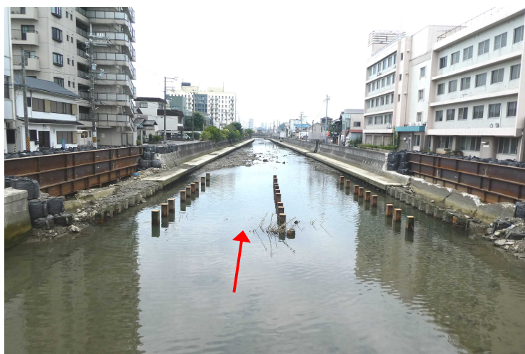
図4-4 0.6k付近（新町橋から下流側を望む）
