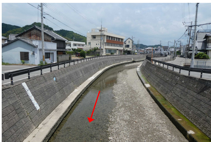
図4-6 1.2k付近（東橋から上流側を望む）
