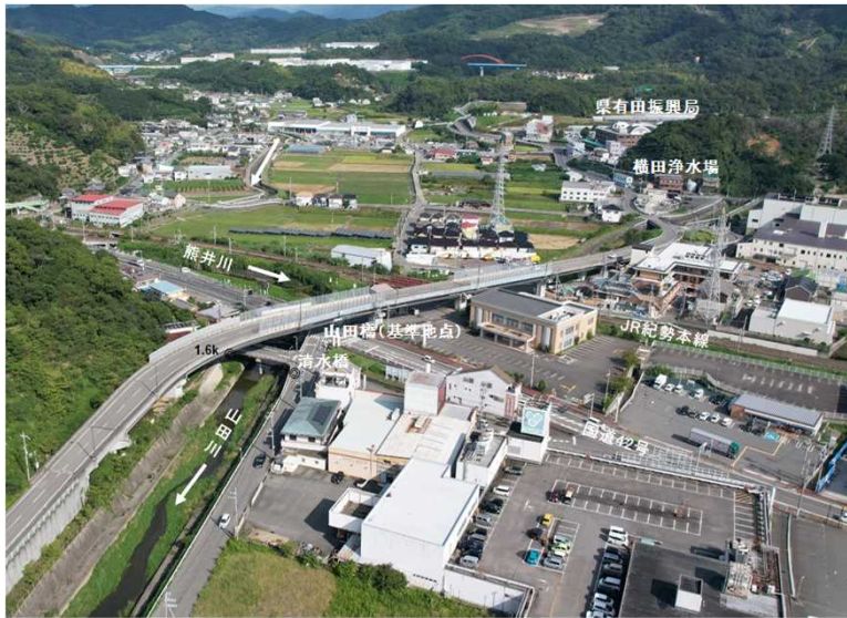
【支川熊井川合流点付近】
