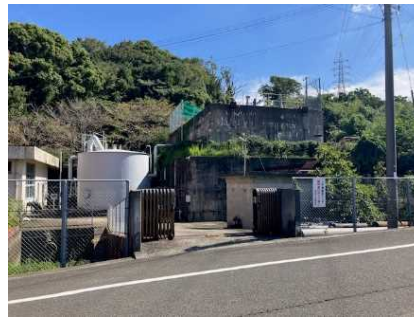
【湯浅町横田浄水場(水道用水)】
