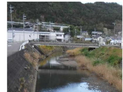
【下流から見たかえる小橋】
