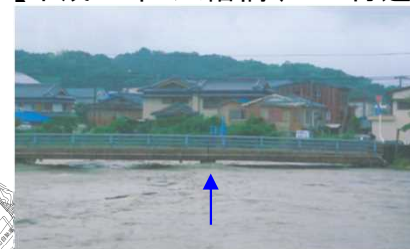
【平成18年 八幡橋(0.7k付近)】
