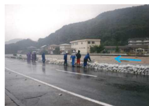
平成13年8月 望見橋より下流付近(0.8k)
