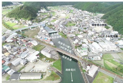
図 1-3 周参見川河口付近
