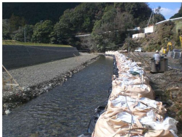
写真 工事による濁水の河川への流出防止
