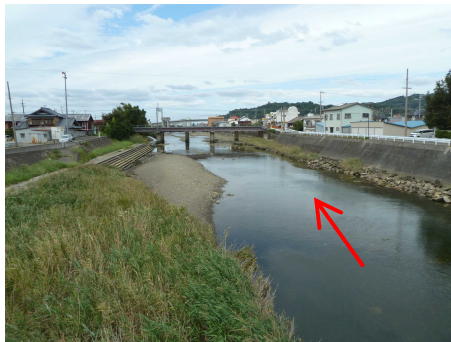
広橋下流 (0.3k 付近)
