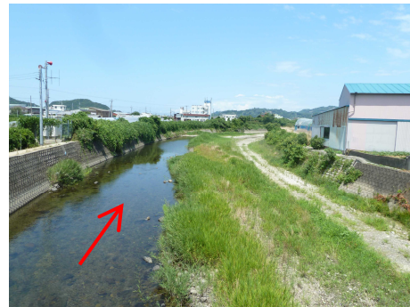
名島橋下流 (1.3k 付近)
