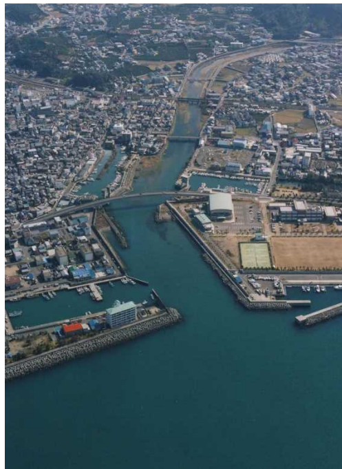
下流域(平成13年) 河口～0.9k 河口付近
