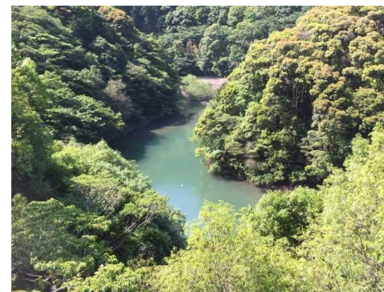
広川ダム貯水池(上流側)
