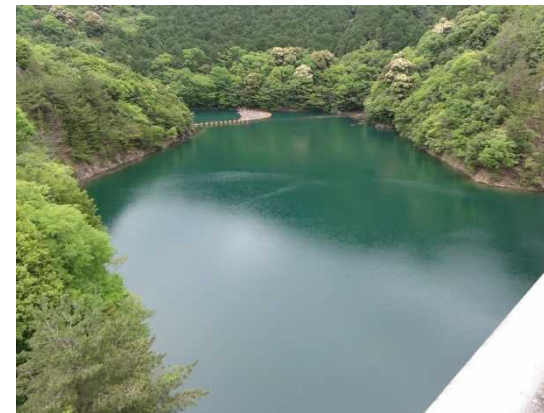
広川ダム貯水池(下流側)
