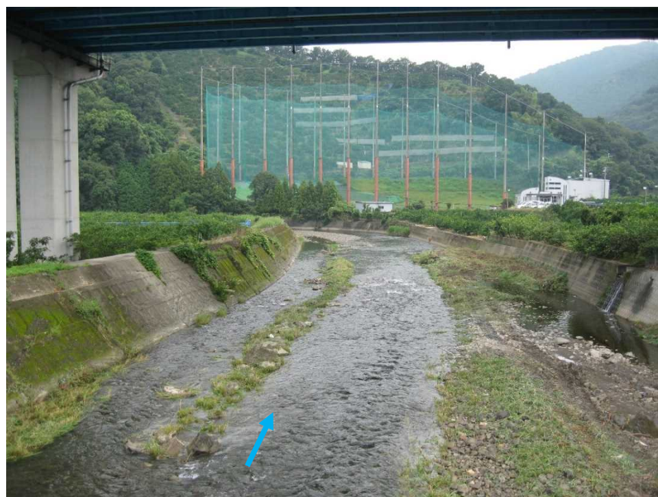
図 3.12 井関大橋より下流を望む
