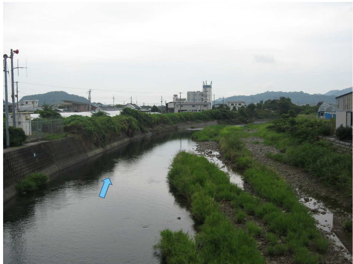
名島橋下流（写真は 1.3km 地点）
