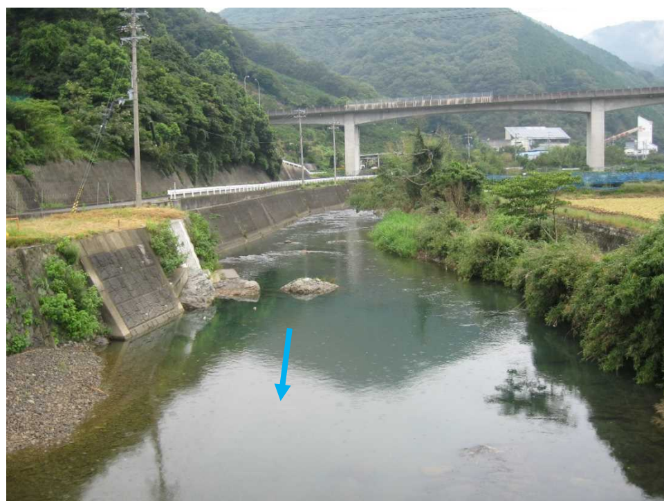
図 3.13 河瀬大橋より上流を望む
