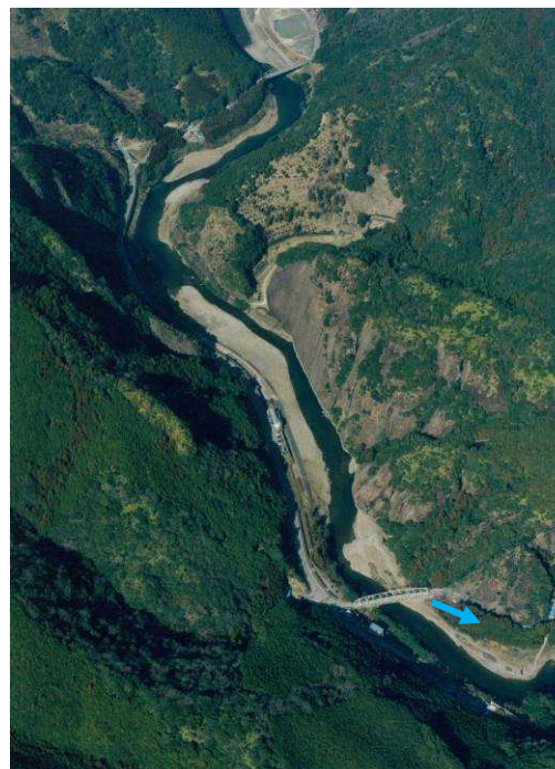
中流域(平成13年) 15.0k~16.0k 相瀬大橋付近
