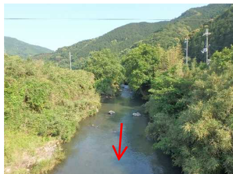
妙見橋上流 (7.0k 付近)
