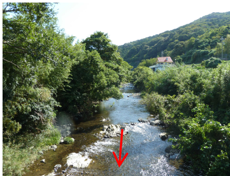
大滝橋上流 (4.5k 付近)
