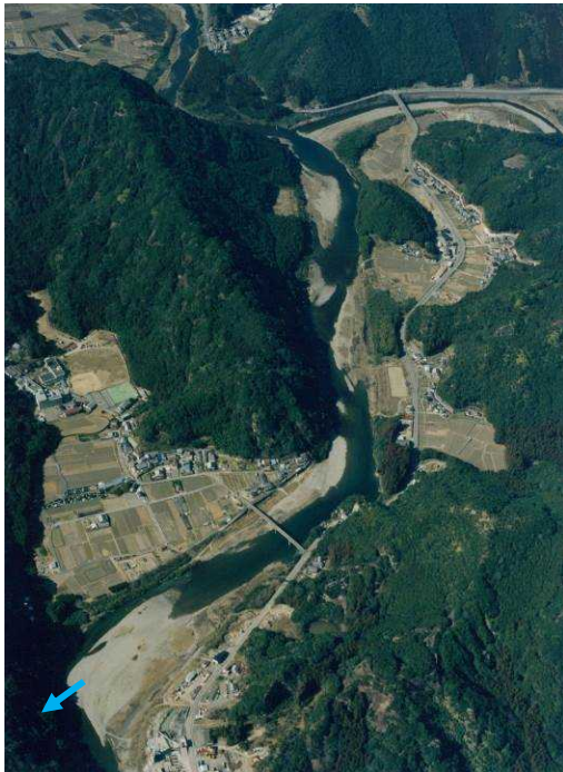
下流域（平成 13 年） 4.0k～7.0k （高瀬橋付近）
