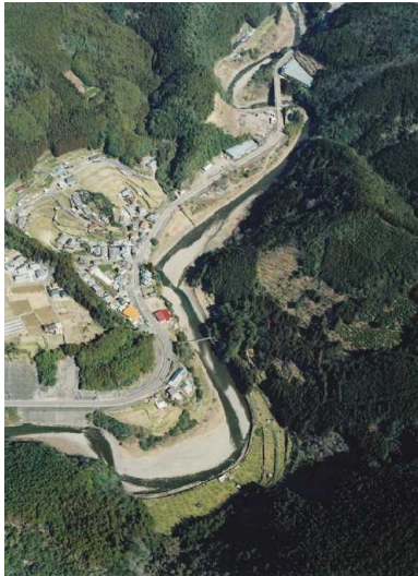
渓流域 30.5kp 付近 ( みよし 三善橋付近)
