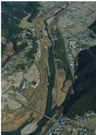
下流域 3.3kp～5.2kp ( しろさぎ 白鷺橋付近)
