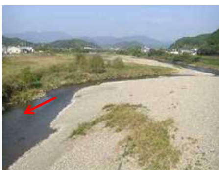
生馬橋上流 (8.0k 付近)
