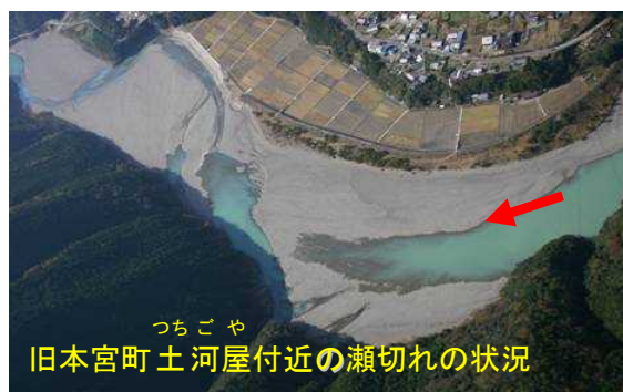
写真1 瀬切れ状況写真 (H16.11.29)
