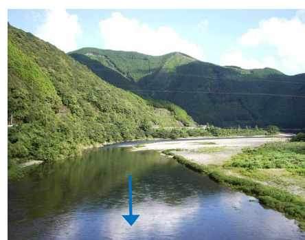
宇津木橋上流 (20.8k 付近)
