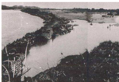
現 御坊市藤田町吉田付近 (右岸側)
