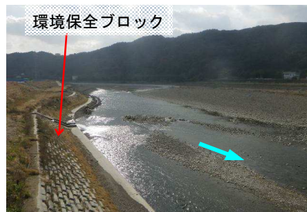
図 2.32 環境に配慮した護岸整備状況（日高川若野地区）
