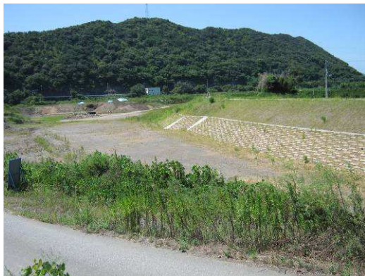
若野頭首工（7.4k 付近）から下流を望む
