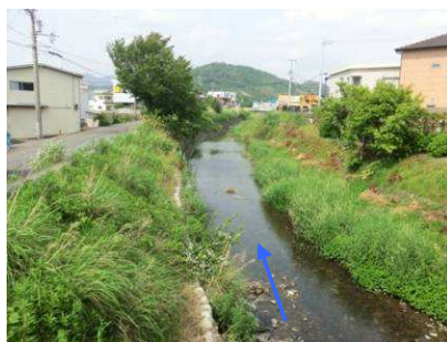
齊川 かいせき 皆堰橋より下流を望む (0.9k 付近)
