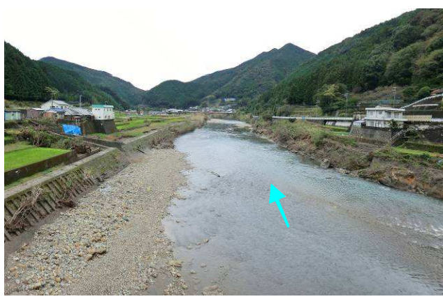
原日浦橋 (40.1k 付近) から下流を望む
