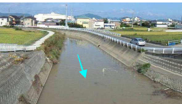
齊川大橋 (0.0k 付近) から上流を望む
