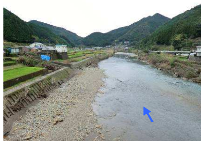
はらびうら 原日浦橋下流 (40.1k 付近)
