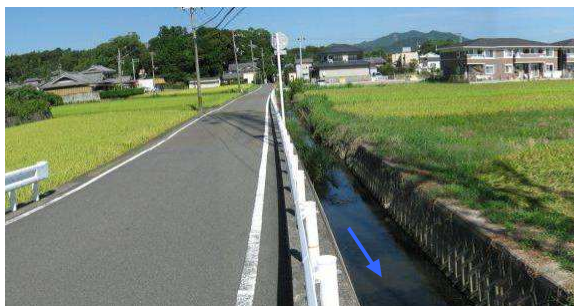
堂閉川 やはた 八幡橋上流 (0.0k)
