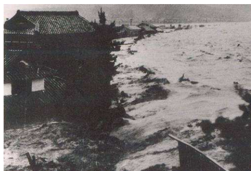
現 野口橋より下流付近 (右岸側)
