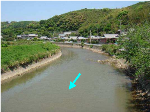
中橋 (4.0k 付近) から上流を望む
