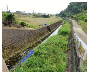
齊川 よしだ 吉田橋より下流を望む (3.2k 付近)
