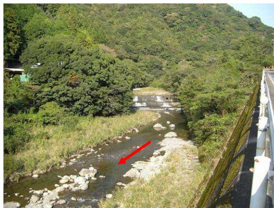
二川橋上流の堰堤
