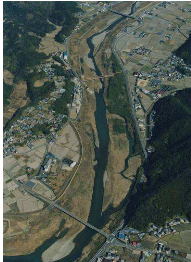
下流域 (2001 年) 3.3kp～5.2kp (白鷺橋付近)
