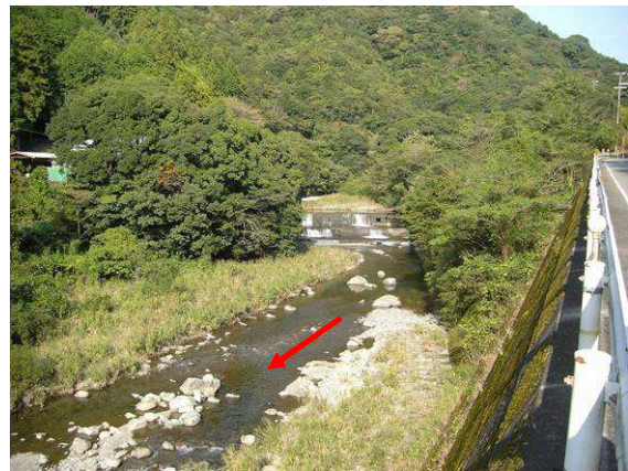
二川橋上流の堰堤
