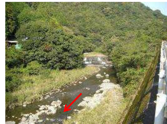
二川橋上流の砂防堰堤
