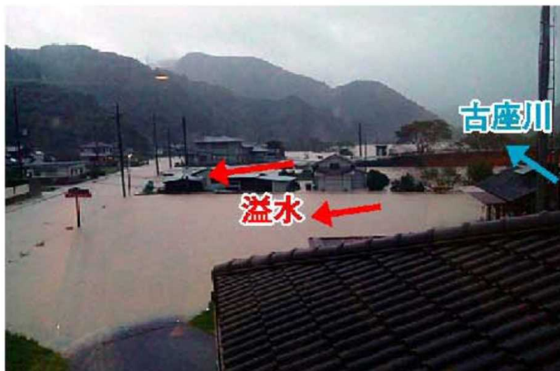
平成23年9月3日氾濫状況 (古座川町明神地区潤野橋付近)
