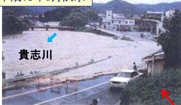
国道424号冠水状況
