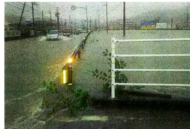
荊木地区（国道）の浸水状況
