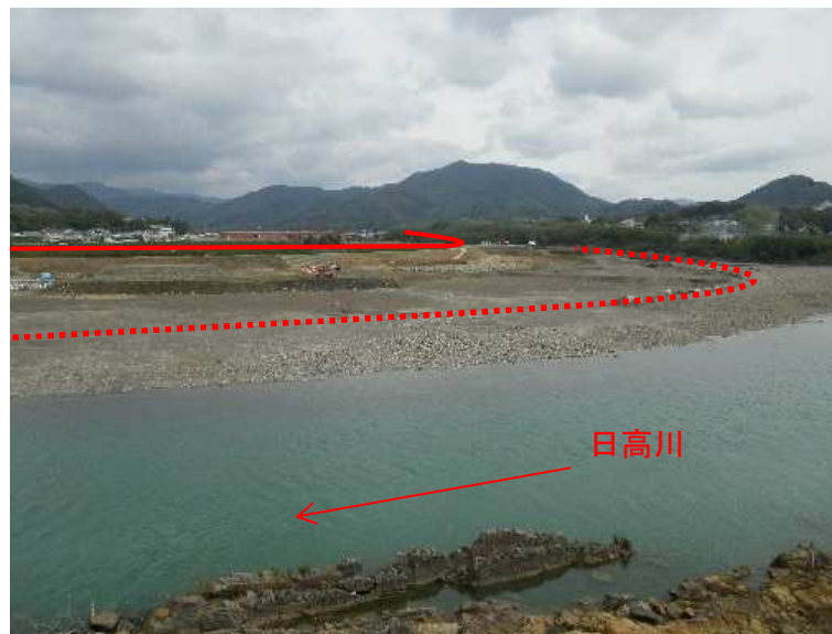
若野地区の引堤工事の状況
