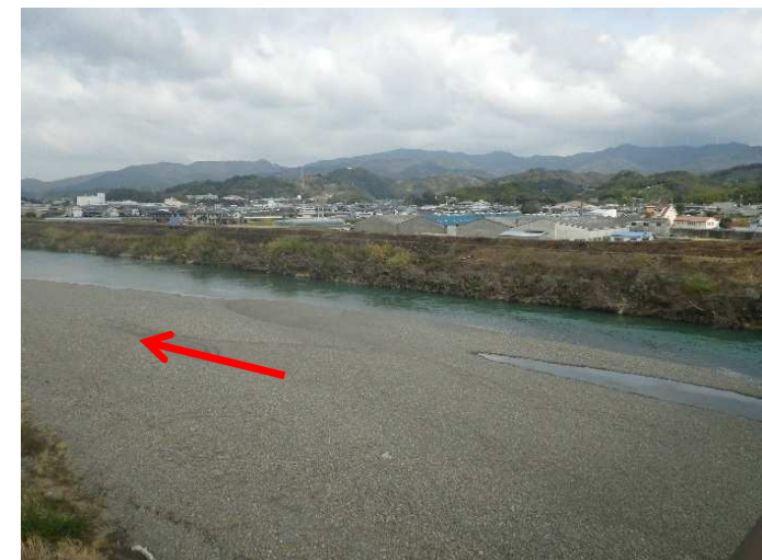
先掘状況 【小熊地区】
