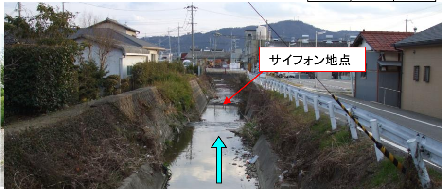
藤崎井用水直上流橋より下流を望む
