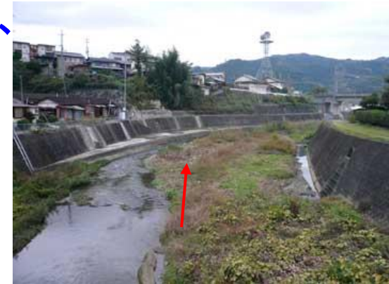
みとの橋水位観測所付近下流(0.6k)
