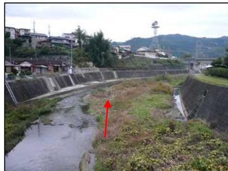
みとの橋水位観測所付近下流 (0.6k)
