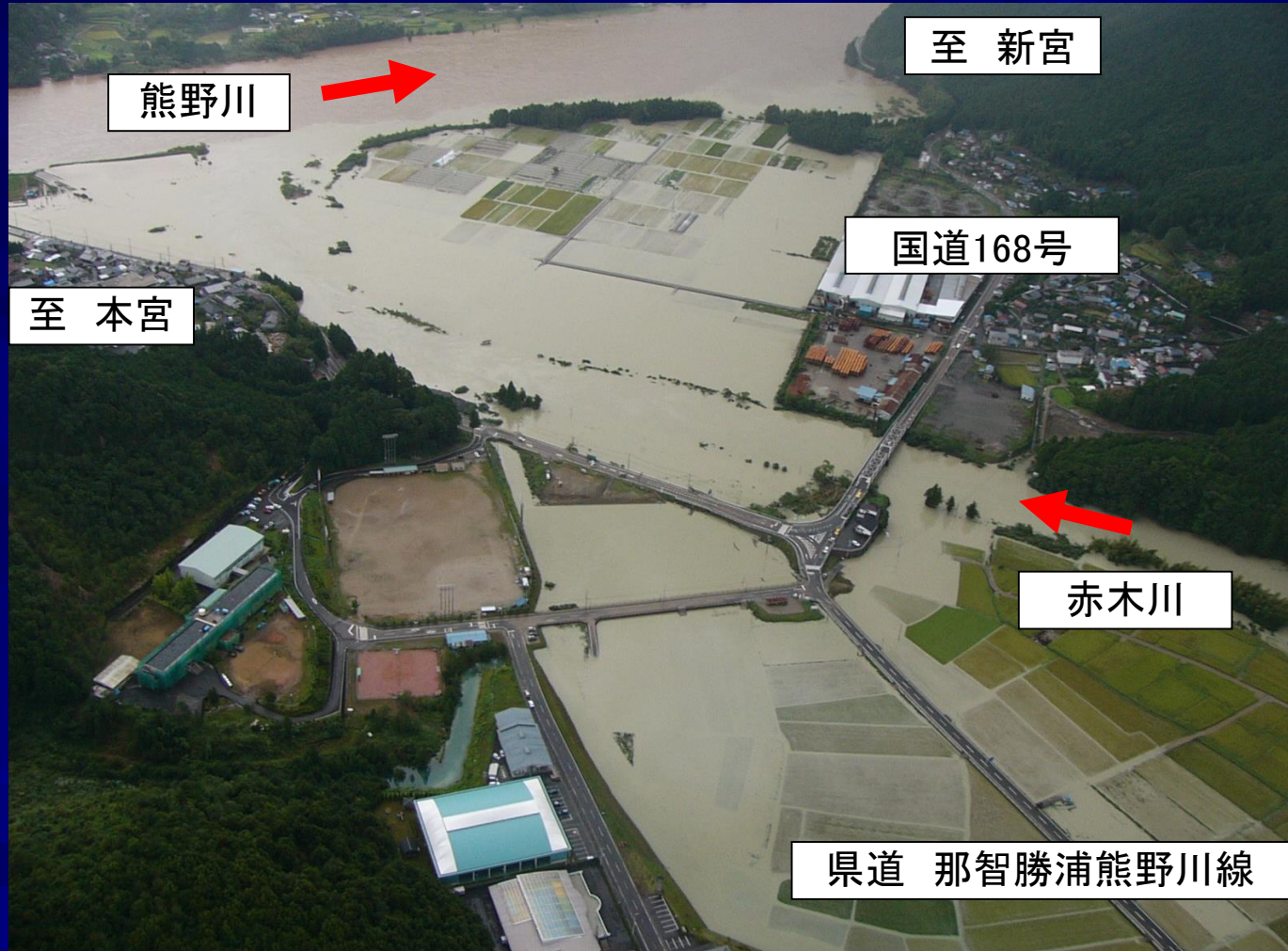
平成16年8月 熊野川と赤木川との合流点（浸水状況）
