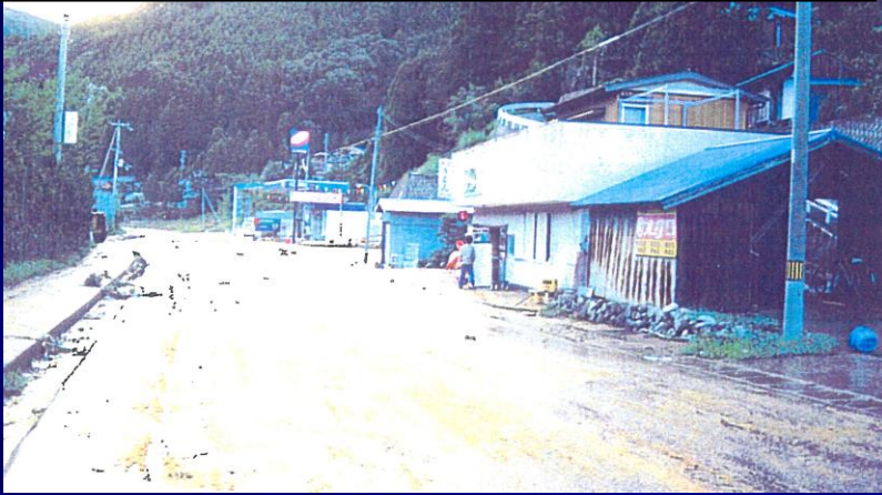
能城山本（国道168号新宮方向を望む）
