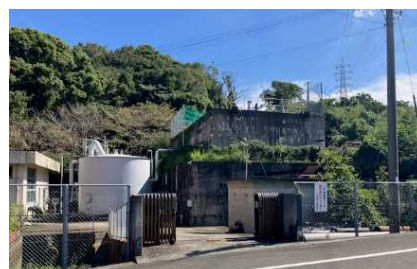
図 2-7 湯浅町横田浄水場（水道用水）
