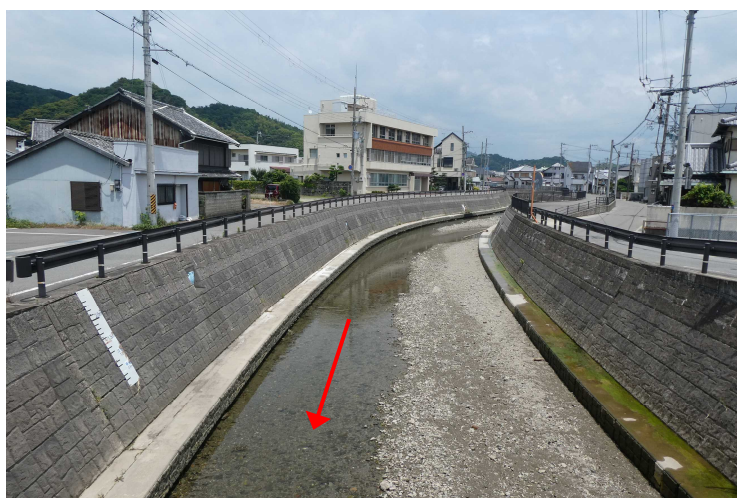
図4-6 1.2k付近（東橋から上流側を望む）
