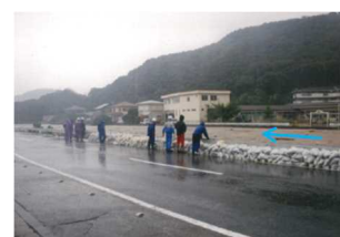
平成13年8月 望見橋より下流付近(0.8k)
