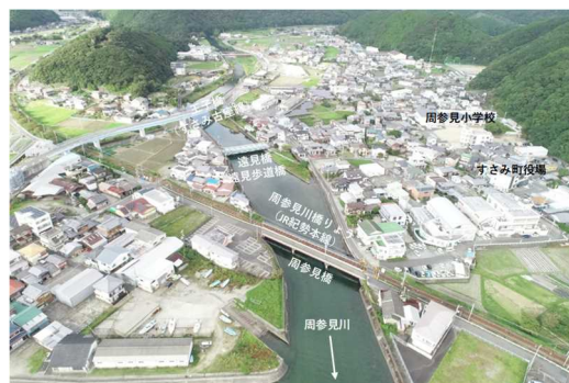
図 1-3 周参見川河口付近
