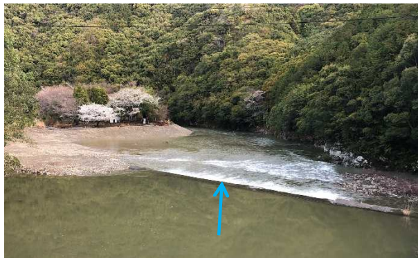
周参見川浚渫状況（原井堰付近）
