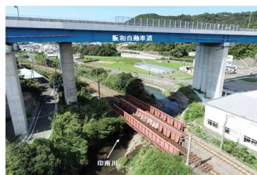
図 1-2 印南川・阪和自動車道付近
